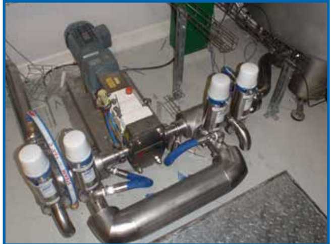
Liquide pompé - sirop de glucose 80 °Bx Pompe - LPX50-1 avec couvercle chauffant et double garniture mécanique
