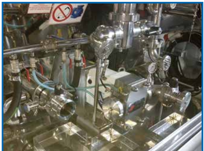
Liquide pompé - transfer de sirops, chocolat, etc. Pompe - LPX80-1 installée sur une citerne de camion
